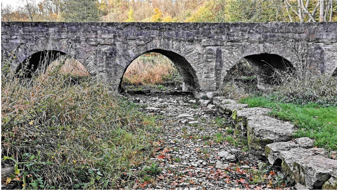
Almebrücke Wewelsburg November 2022
